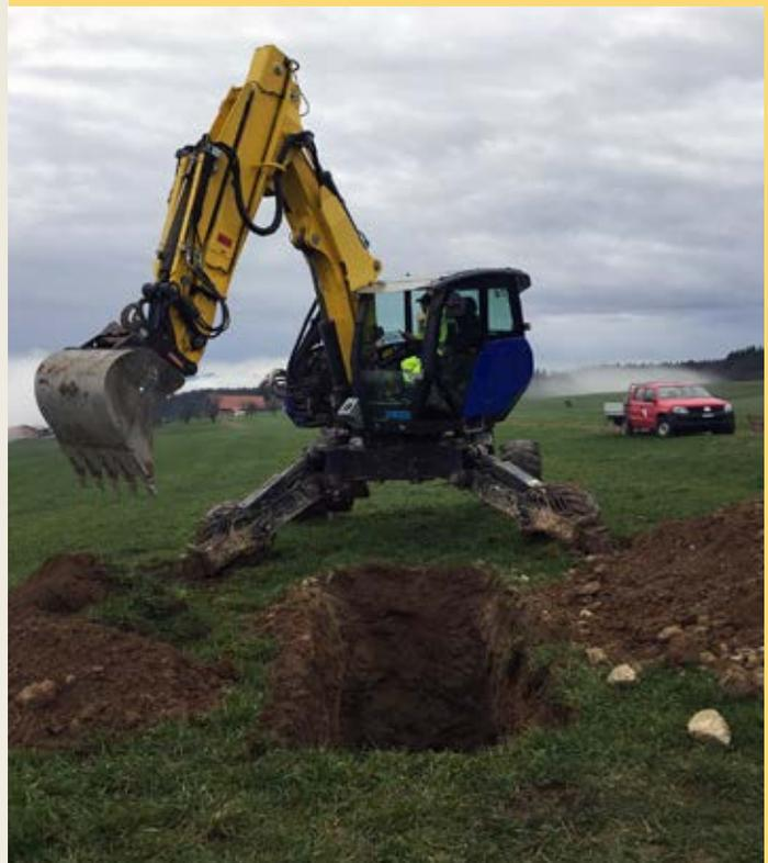
**Abb. 2: Baggerarbeiten an einem Sondierschacht im Gebiet Grod / Nord.**
